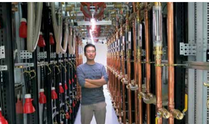
Voorbeeld van een moderne bitcoinmijn, ASCIMiner, in Hongkongs Kwai Chung. De koelinstallaties staan op het dak van het gebouw.
